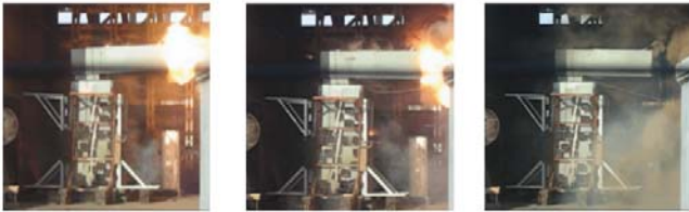
성공적인 ArcShield 시험의 실제 사진
