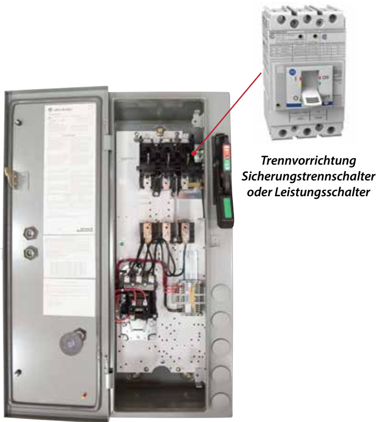
512 Direktstarter plus Lasttrennschalter mit sichtbaren Messerkontakten
