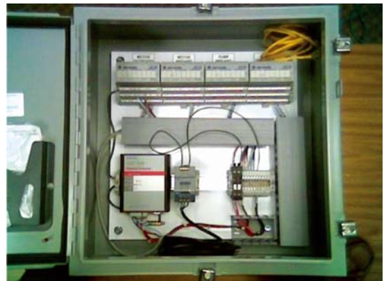
XM模块安装示意图
