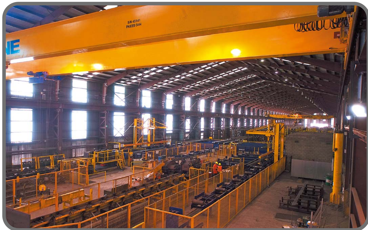
チェーンコンベヤ網、ローラ遷移テーブル、天井クレーンを使用して鋼材を圧延工程で操作します。
